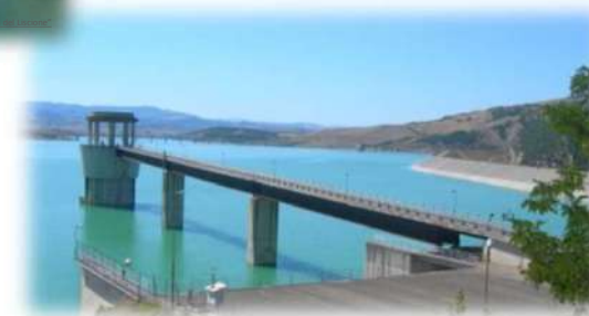
Invaso di Montecotugno (PZ)
